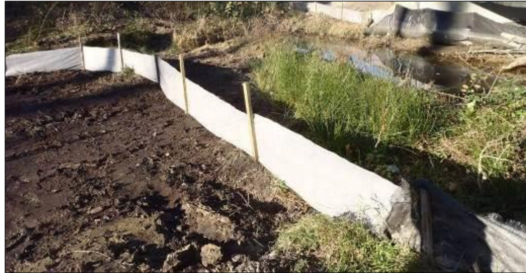
Figure 26 : Implantation de barrières amphibiens en géotextile permettant d'éviter les déplacements des individus du cours d'eau vers le chantier © ETEN Environnement
