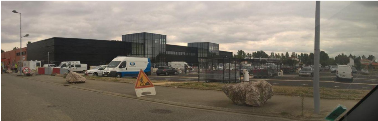
À l'entrée Nord du site, les bâtiments d'Intermarché, rénovation/extension, et les commerces structurant le site
