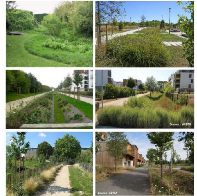
Exemples d'aménagements de voies douces, de noues végétalisées et de bassins d'orage
