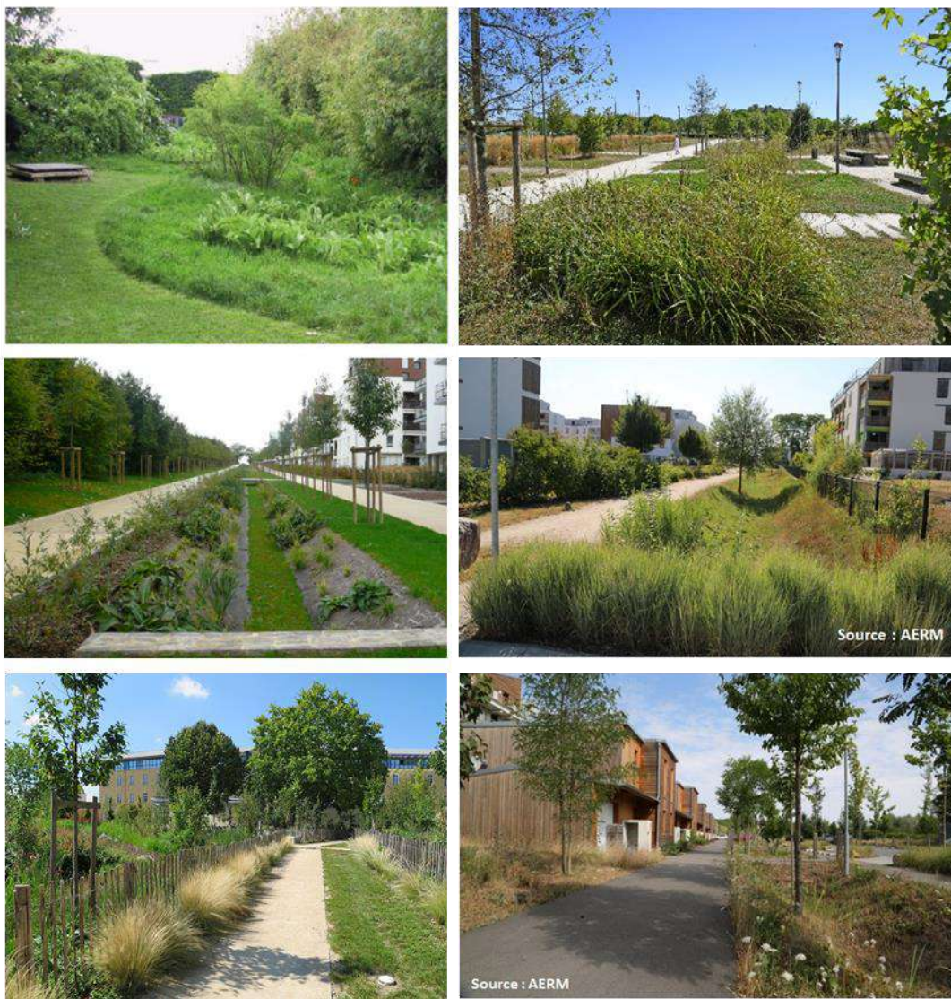
Exemples d'aménagements de voies douces, de noues végétalisées et de bassins d'orage
